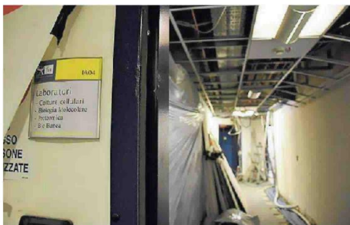
Il cantiere per la realizzazione del nuovo laboratorio di genomica
